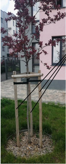
Конструкция деревянных опор для вновь посаженных деревьев
